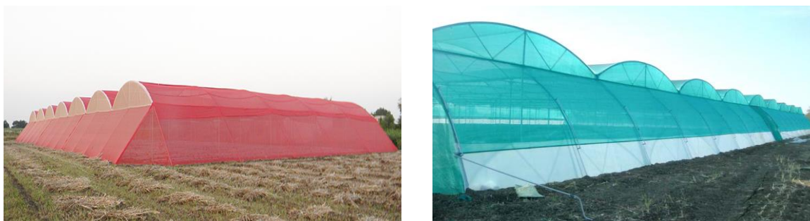
شکل ۵- نمایی از سازه‌های توری‌دار با سقف قوسی مناسب برای منطقه چابهار (۸، ۹).
