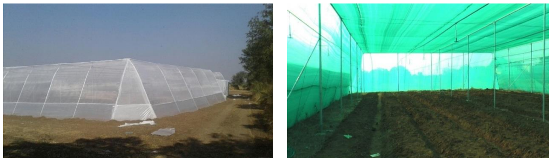
شکل ۷- نمایی از سازه‌های توری‌دار با سقف مسطح مناسب برای منطقه چابهار (۹).
