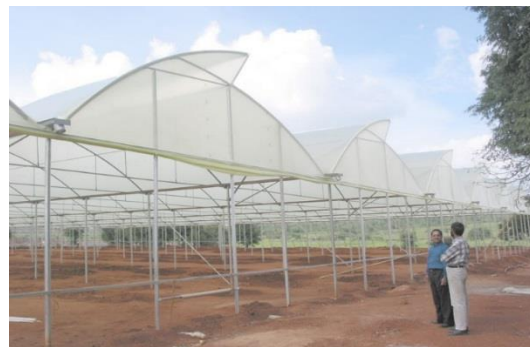
شکل ۲- نمونه‌هایی از سازه‌های ساده و ارزان دارای تهویه طبیعی مناسب برای گیاهان در منطقه‌های استوایی و نیمه‌استوایی (۸).
