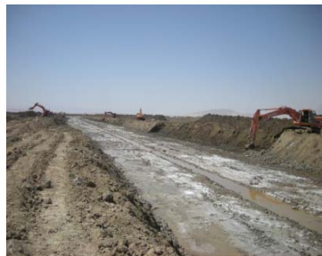
شکل ۱۹- بستر مرکب کانال انحراف زرينه رود.
