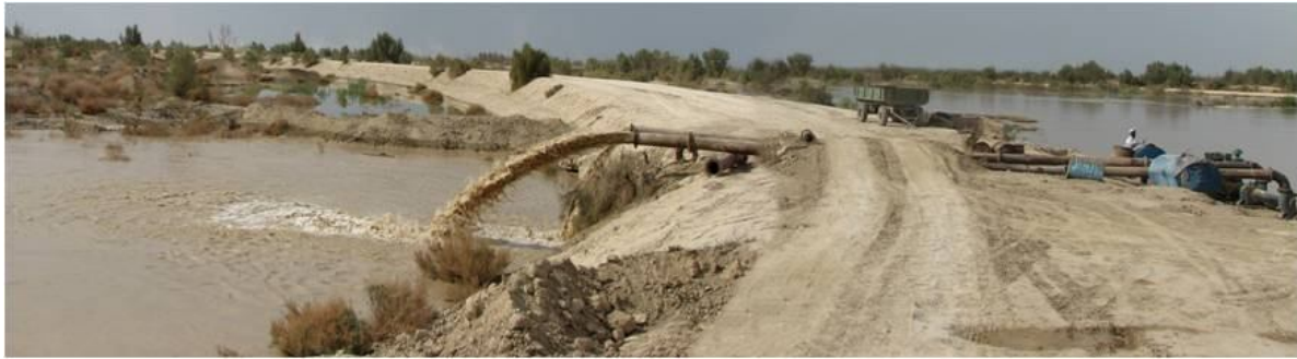
شکل 1: روش انتقال سیلاب با استفاده از تلمبه‌های موتور دیزلی را نشان می‌دهد.
